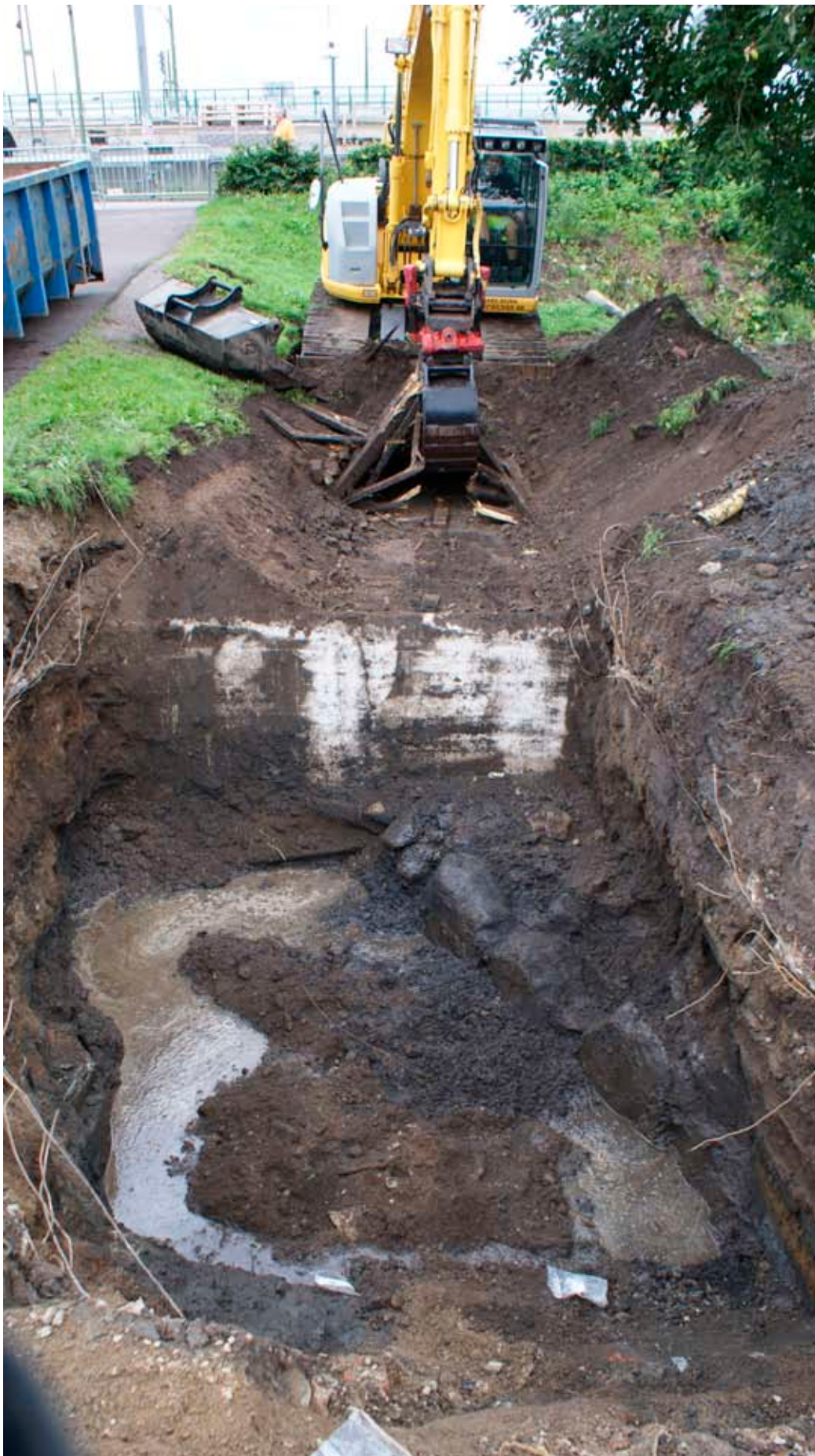
III. 9. Foto över schakt 3 och den påträffade grundmuren som framkom i lager 9. Foto mot väst.
