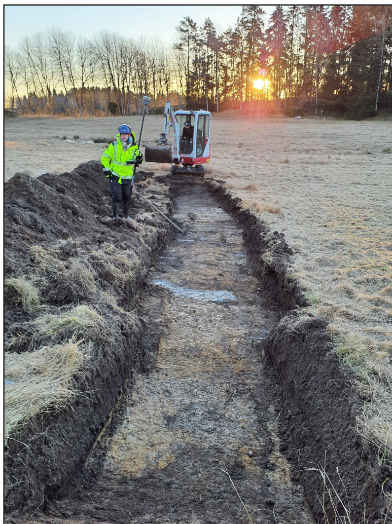
Figur 6. Lagerföljd i schakt 1. Foto mot sydost.
