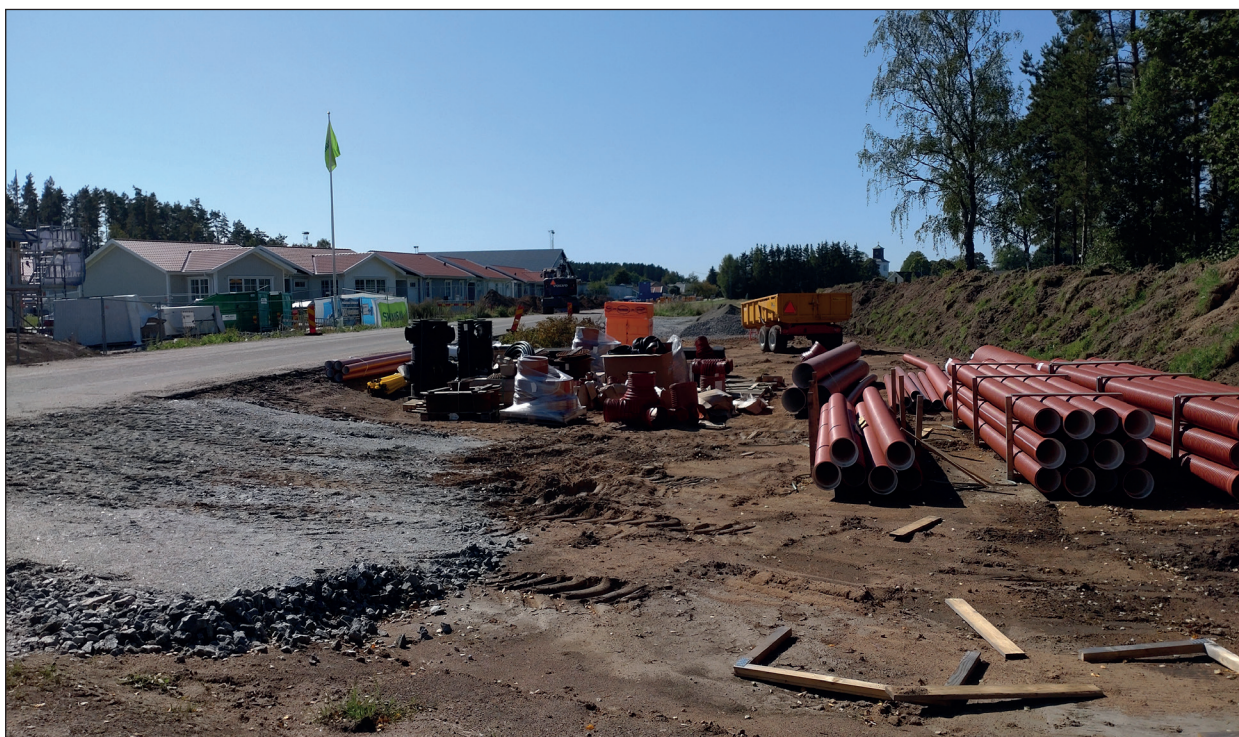
Figur 6. Undersökningsytan användes vid ankomst som upplag för diverse byggmaterial.
