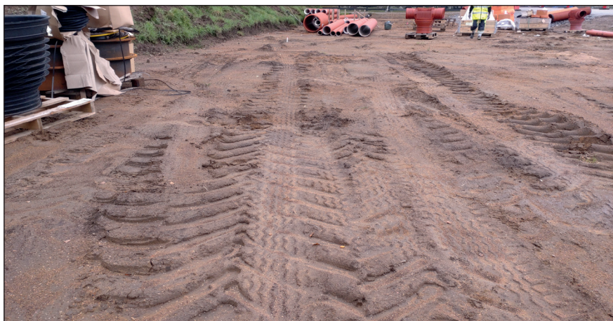
Figur 7. Hjullastare och andra maskiner hade lämnat tydliga körspår efter sig på ytan.
