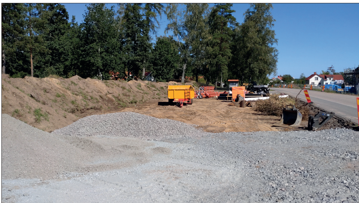
Figur 11. Entreprenaden hade lagt upp dumphögar i norra delen av ytan samt påfört makadam i nordost och sydväst för att underlätta maskintrafik.
