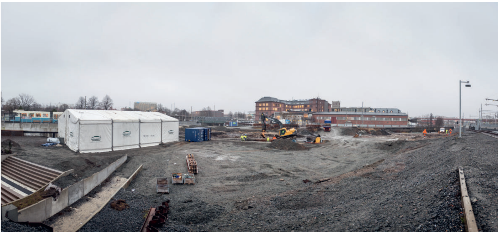
Figur 6. Ytan i denna rapport vid fältarbetets start i februari 2015. Foto från nordväst Markus Andersson.
