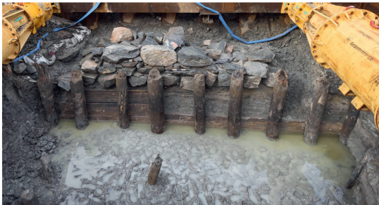
Figur 46. Kajkant från Masthamnen i Göteborg, konstruerad på 1640-talet och undersökt 2019–2020 i samband med bygget av Västlänken. Konstruktionen är mycket lik de i Nya Lödöse med en stenmur och nedslagna pålar. Foto: Markus Andersson.
