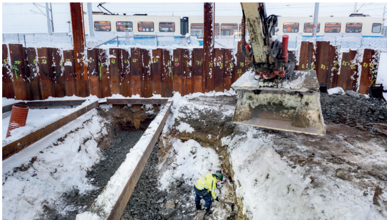
Figur 15. Kajsa Andreasson undersöker ytan närmast Bergslagsbanan (innanför spanten) i januari 2016. Foto: Markus Andersson.
